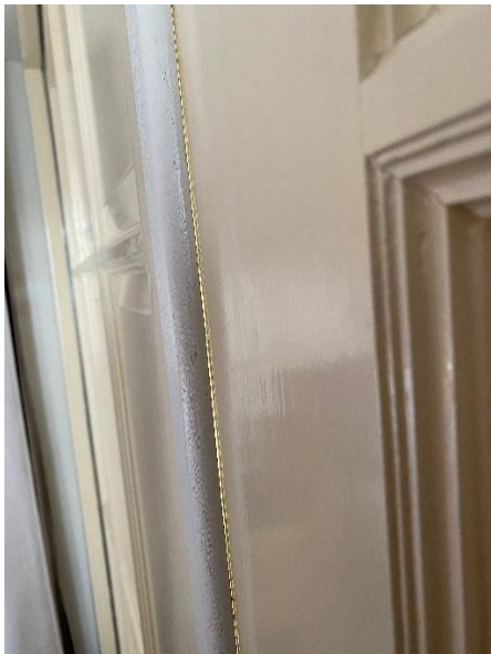
Figuur 4 kier tussen tochtprofiel en voordeur
