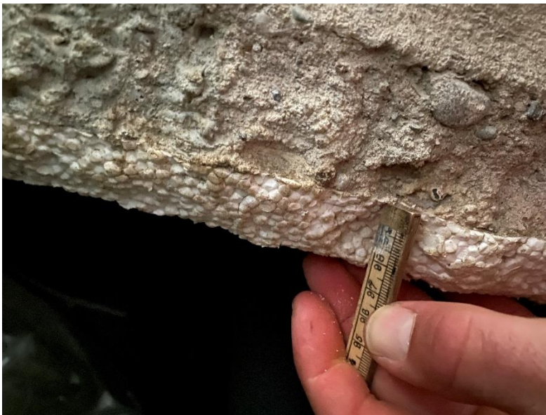
Figuur 1 EPS isolatielaag tegen betonnen balken-broodjesvloer
