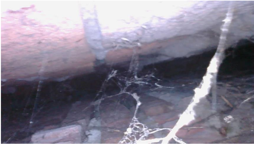
Figuur 2 spouwbeeld buitengevel
