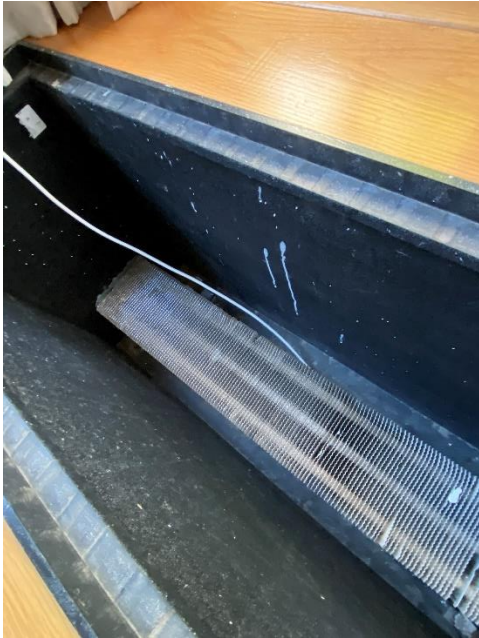
Figuur 5 Eén van de convectorputten, geopend
